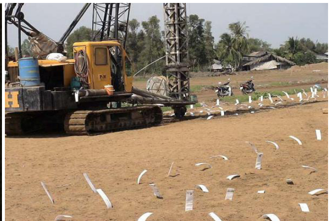
Thi công bắc thấm đứng
