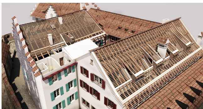
Ảnh chi tiết mái của công trình.
