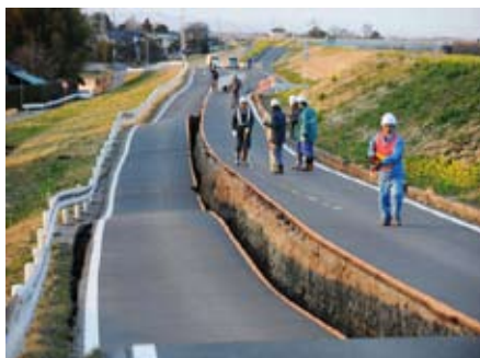
Tác động của đất hóa lỏng đối với các công trình xây dựng
