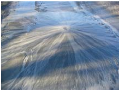
Đất cát phun trào lên mặt đường - một hiện tượng của đất hóa lỏng
