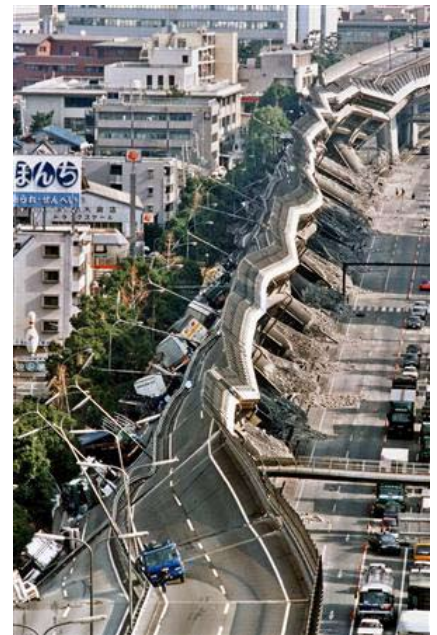
Đường cao tốc Hanshin tại thành phố cảng Kobe (Nhật Bản) sau trận động đất năm 1995
