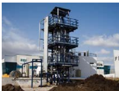
Nhà máy xử lý chất thải sinh học bằng công nghệ thủy nhiệt có công suất 2.000 tấn/năm tại Valencia, Tây Ban Nha.
