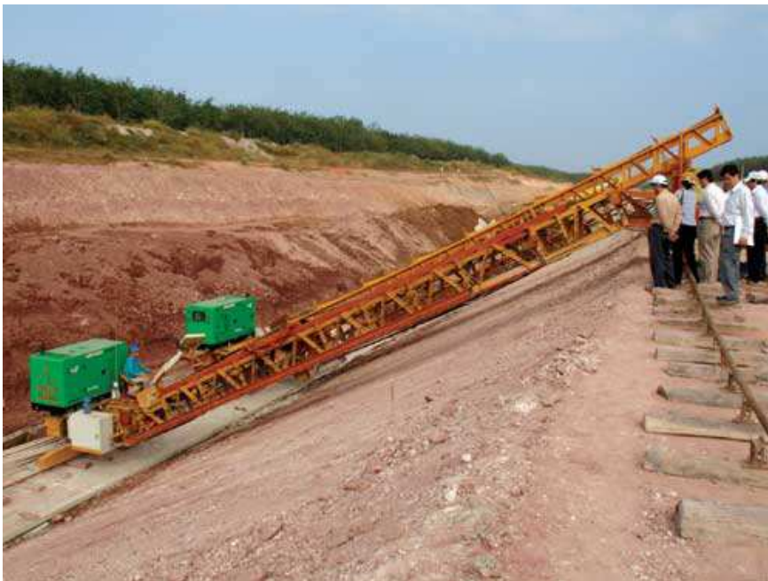
Thiết bị đổ bê tông mái dốc cho bờ kênh, rạch - đề tài được giải 2 tại Hội thi sáng tạo kỹ thuật TP. HCM
