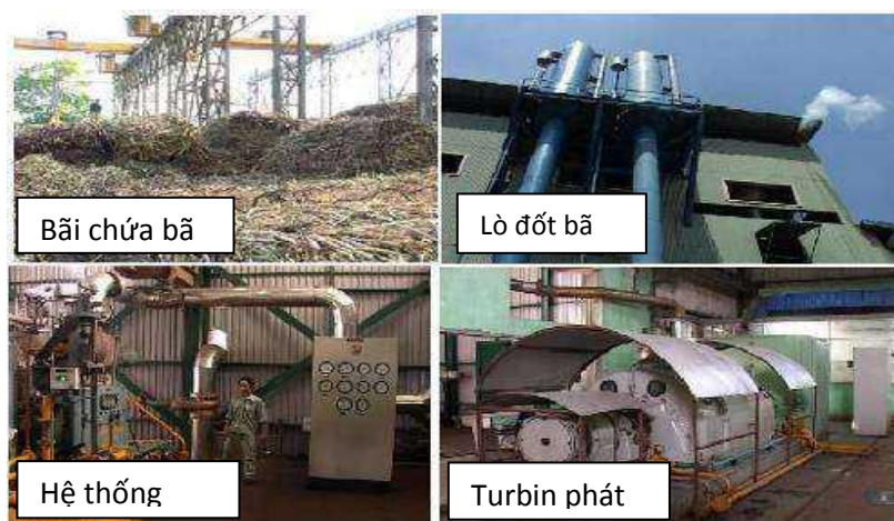
Hình 22: Hệ thống sản xuất điện từ bã mía ở nhà máy đường.
