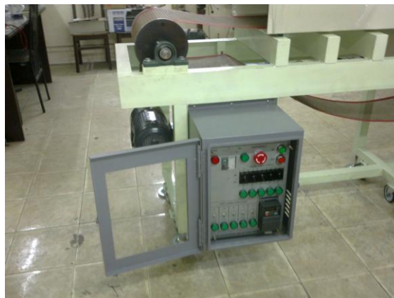
Hình 44: Lắp đặt tủ điều khiển
