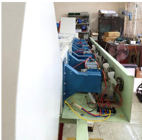
Hình 45: Lắp đặt thiết bị công suất cho các đèn phát (magnetrons)
