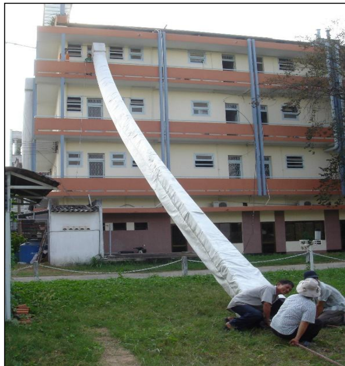
Hình 22: Cấu tạo và phương pháp lắp ống tuột nghiêng đối diện
