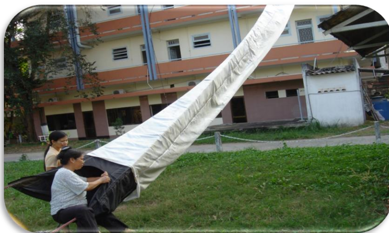
Hình 26: Lắp đặt ống tuột nghiêng
