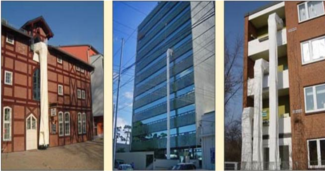
Hình 16: Ống tuột đứng được lắp đặt tại chỗ ở các nhà cao tầng
