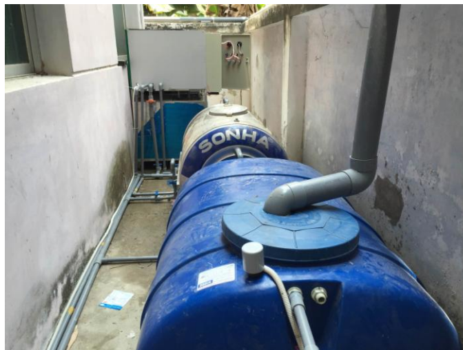
Hệ thống sau khi lắp ráp hoàn chỉnh
