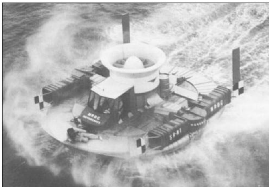
Hình 1.5 - Tàu đệm khí đầu tiên trên thế giới SR.N1 (1959).
